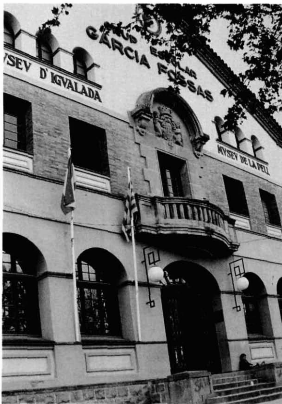
Edifici del actual grup escolar "García Fossas", on es situaren, successivament, dos hospitals militars.
