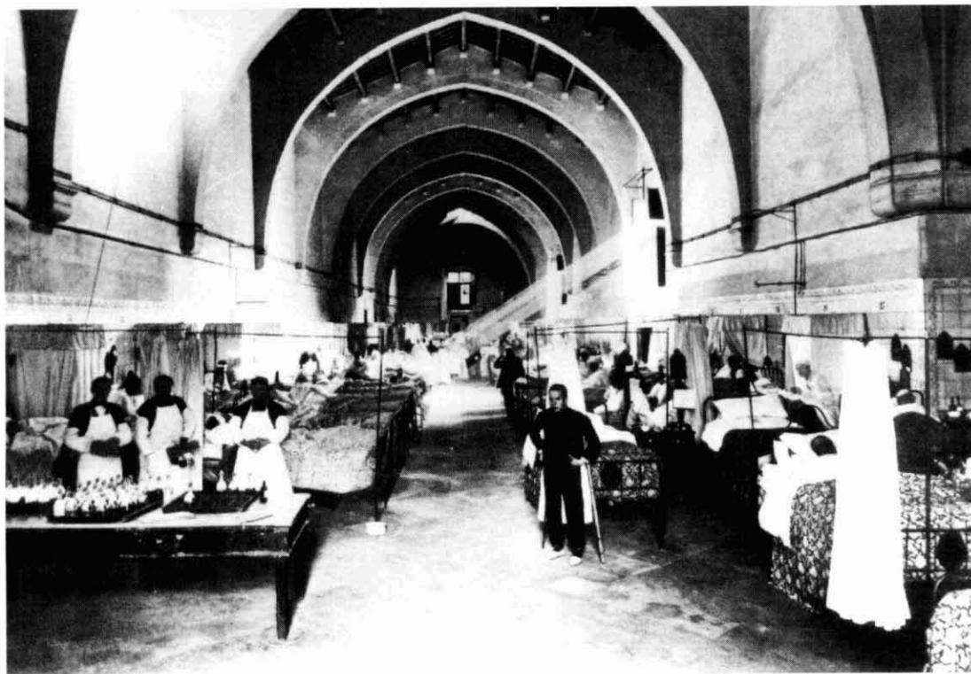
Interior d'una sala de malalts del vell hospital on es feia l'ensenyament de les assignatures clíniques.
