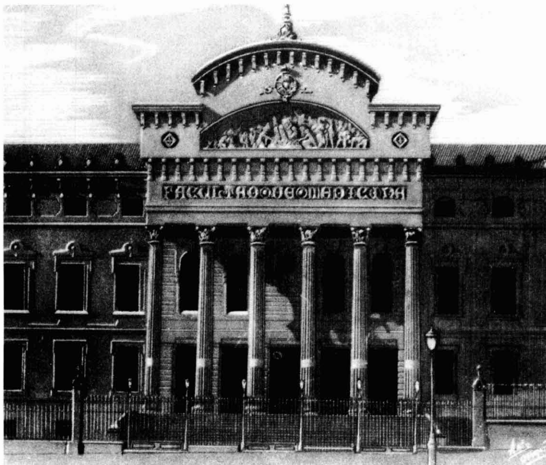
Façana del nou edifici de la Facultat al carrer de Casanova. Fou inaugurat l'any 1906, tot i que les obres van començar el 1888, amb una primera pedra simbòlica. La segona real es posa el 1895.
